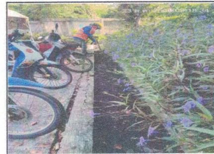
เก็บเศษคก้างดินตะกอน ใบไม้ที่อยู่ในรางระบายน้ำบริเวณสำนักงาน
